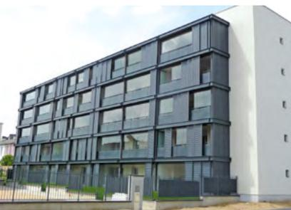
Chaque logement dispose également d'une loggia (balcon que l'on peut fermer) avec des vitres et des brise-soleils coulissants. Les locataires peuvent ainsi les ouvrir l'été pour ventiler et les fermer l'hiver pour accumuler la chaleur apportée par le soleil et la redistribuer dans le logement. Enfin, le bâtiment est équipé de panneaux solaires thermiques permettant de chauffer l'eau et de pompes à chaleur performantes pour les éventuels compléments de chauffage et d'eau chaude.
